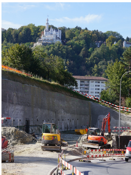
Baugrube Diebold-Schilling-Strasse 29 und 31
